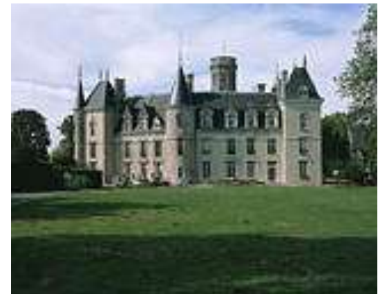
Château de Fontenailles
